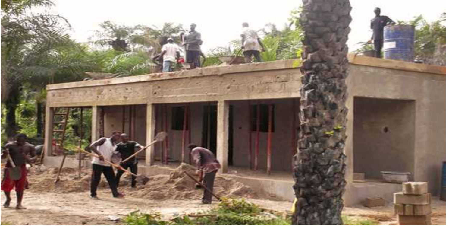
Arbeiter beim Rohbau im Palmenwald
